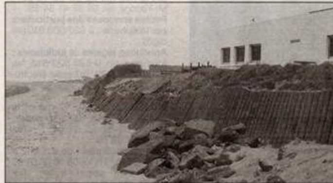
La tempête de 1999 n'a pas épargné la digue de Blainville-sur-Mer. Elle protégeait les deux restaurants, le poste d'observation de la SNSM et la cale. Le conseil municipal a dû faire un choix entre deux procédés: l'enrochement longitudinal (non subventionné) ou l'épi perpendiculaire à la côte.
