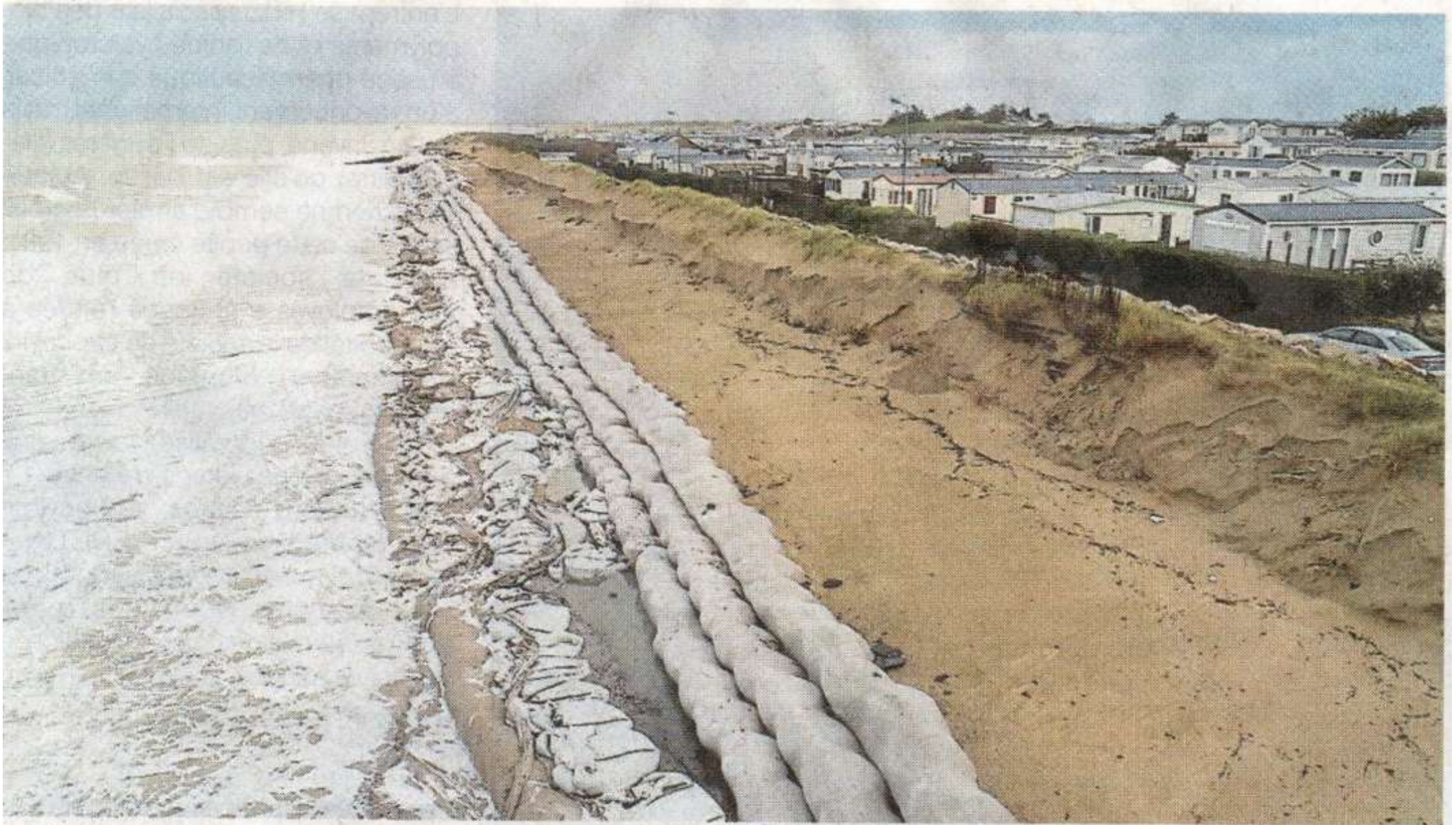
La plage de Gouville-sur-Mer (Manche) et ses Géotubes qui ne suffisent plus à contenir l'érosion. | PHOTO : ARCHIVES THOMAS BRÉGARDIS, O F
