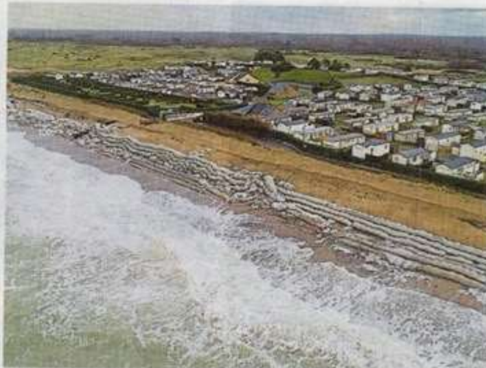
Sur la plage de Gouville-sur-Mer (ici, la camping Belle Etoile), les géotubes, installés en 2017, l'érosion de la dune.
