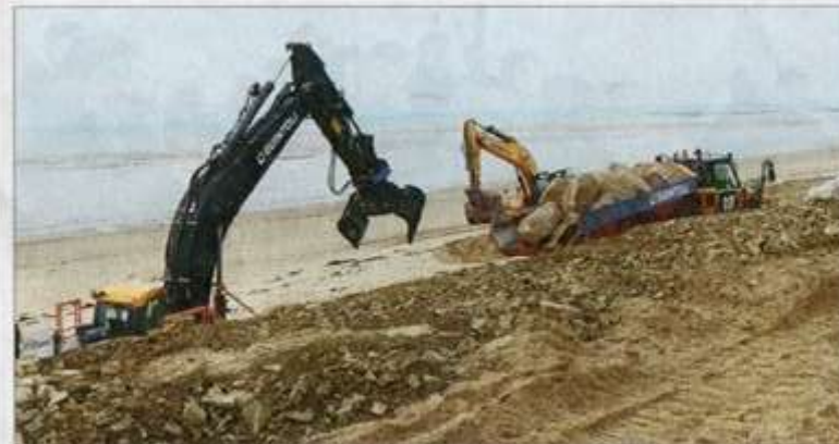
Les travaux devront être terminés pour le 1 er avril. Les grands moyens sont employés.
