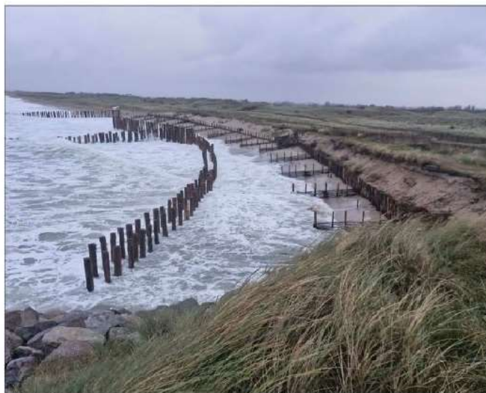
Le littoral ouest de la Manche résistera-t-il longtemps aux coups des vents dominants ? Les moyens de résistance autorisés par la loi sont dérisoires, comme ces pieux en bois à Gouvville-sur-Mer.
