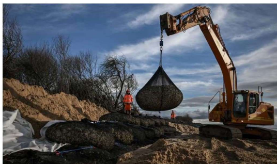
Des ouvriers installent des gabions remplis de pierres sur la plage des Allassins à Grand-Village-Plage, sur l'île d'Oléron.
